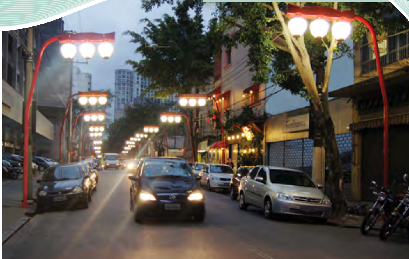
Poste Oriental Bairro da Liberdade – São Paulo
